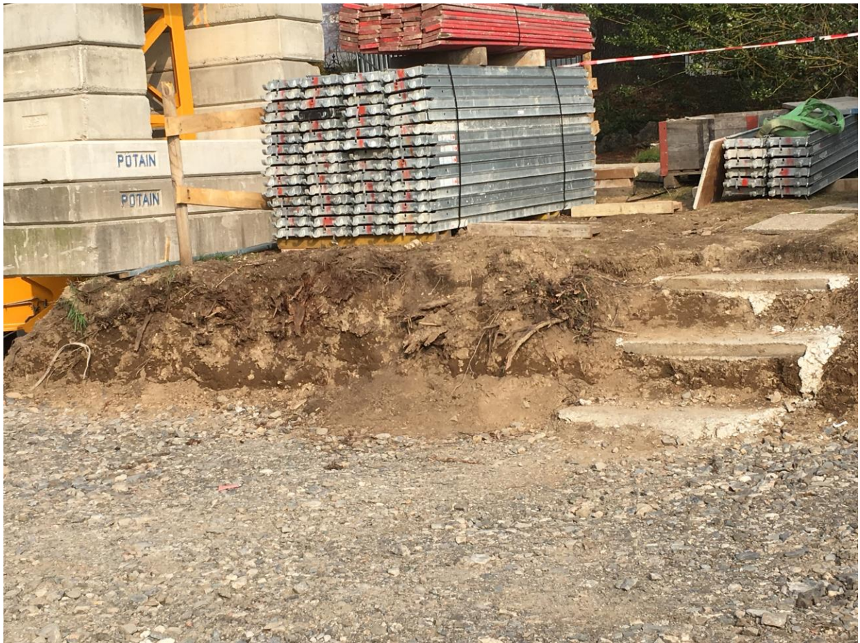
Fotografia del cantiere del 21 febbraio 2021
